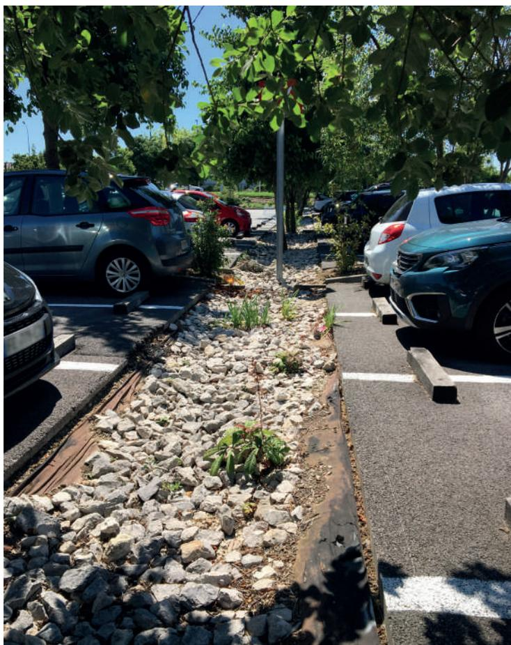
Photo 2 : noue entre les places de stationnement sur un parking de centre commercial (Aout 2021, Plaisir -78)
