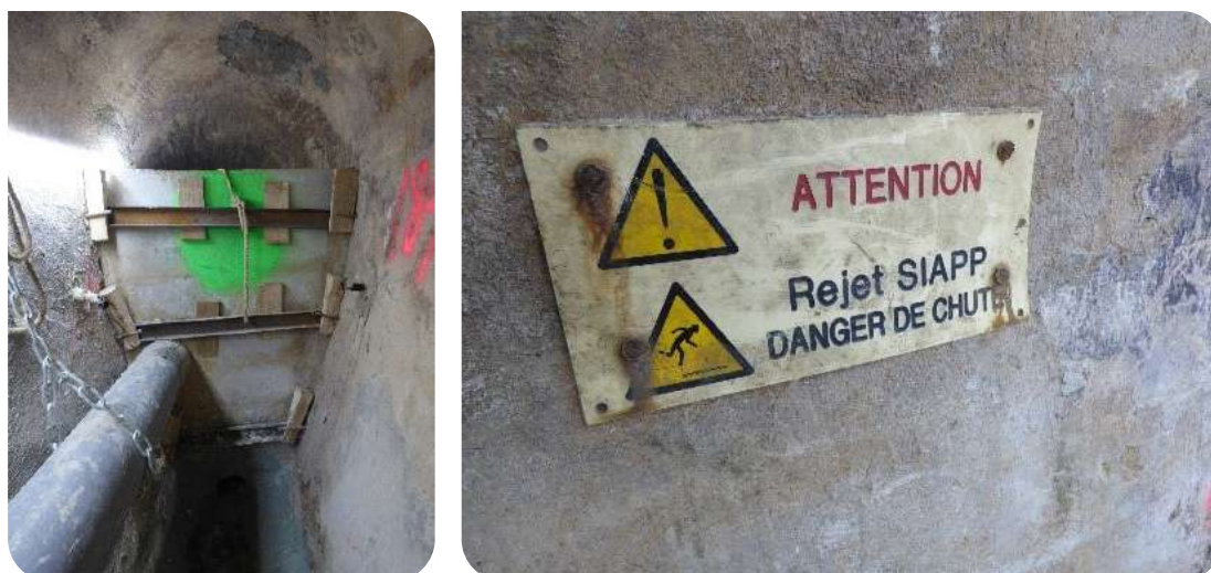
Figure 24 : Mise à sec du collecteur avec construction d'un mur masque côté rejet SIAAP route d'Asnières à Clichy
