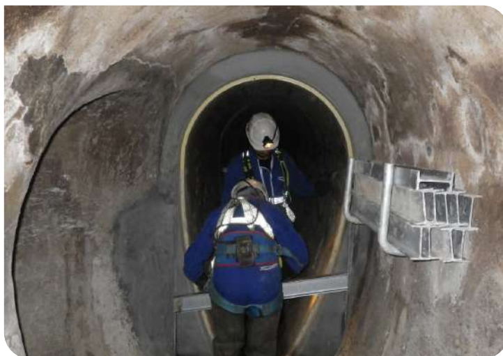
Figure 8 : Mise en place de batardeau dans un ovoïde
