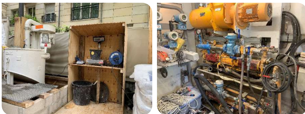
Figure 26 : Centrale d'injection avenue Aristide Briand à Issy-Les-Moulineaux
