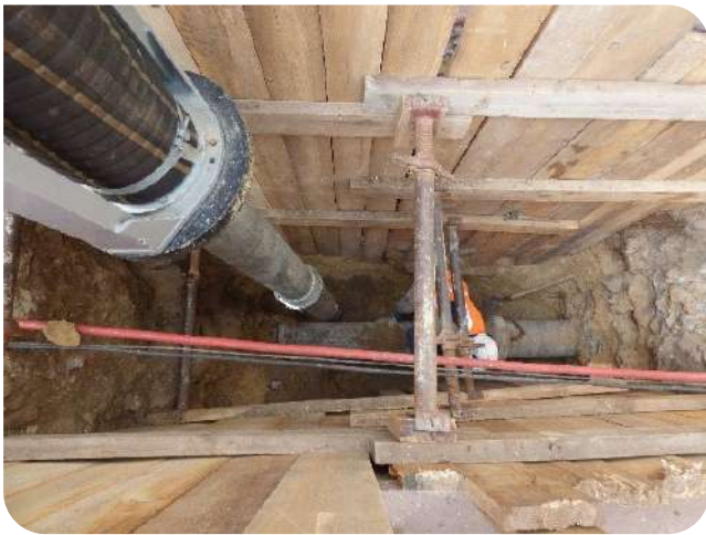
Figure 21 : Renouvellement du collecteur d'assainissement en DN 300 mm en tranchée ouverte rue Lénine à Nanterre
