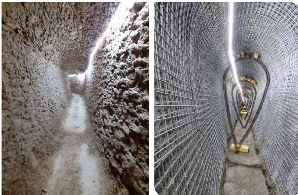
Figure 25 : Démolition des enduits en piédroits et voûte et du radier du collecteur d'assainissement et mise en place d'un étaieement provisoire de l'ouvrage rue Pierre Louvrier à Clamart
