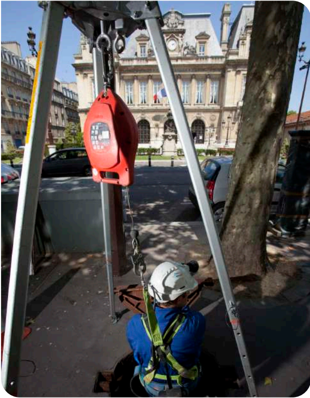
Figure 5 : Descente en égout (Neuilly-sur-Seine)
