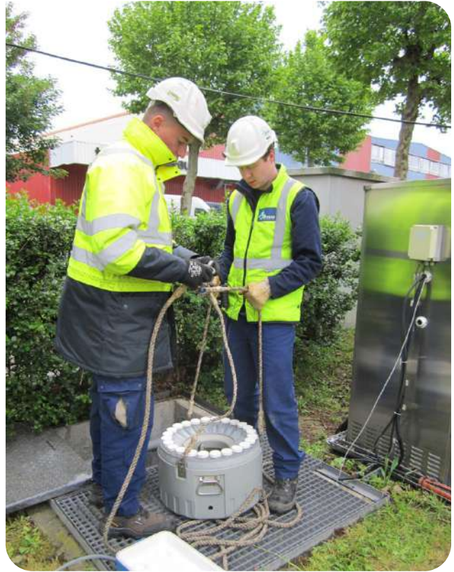
Figure 6 : Mise en place de préleveurs automatiques pour analyse des effluents
