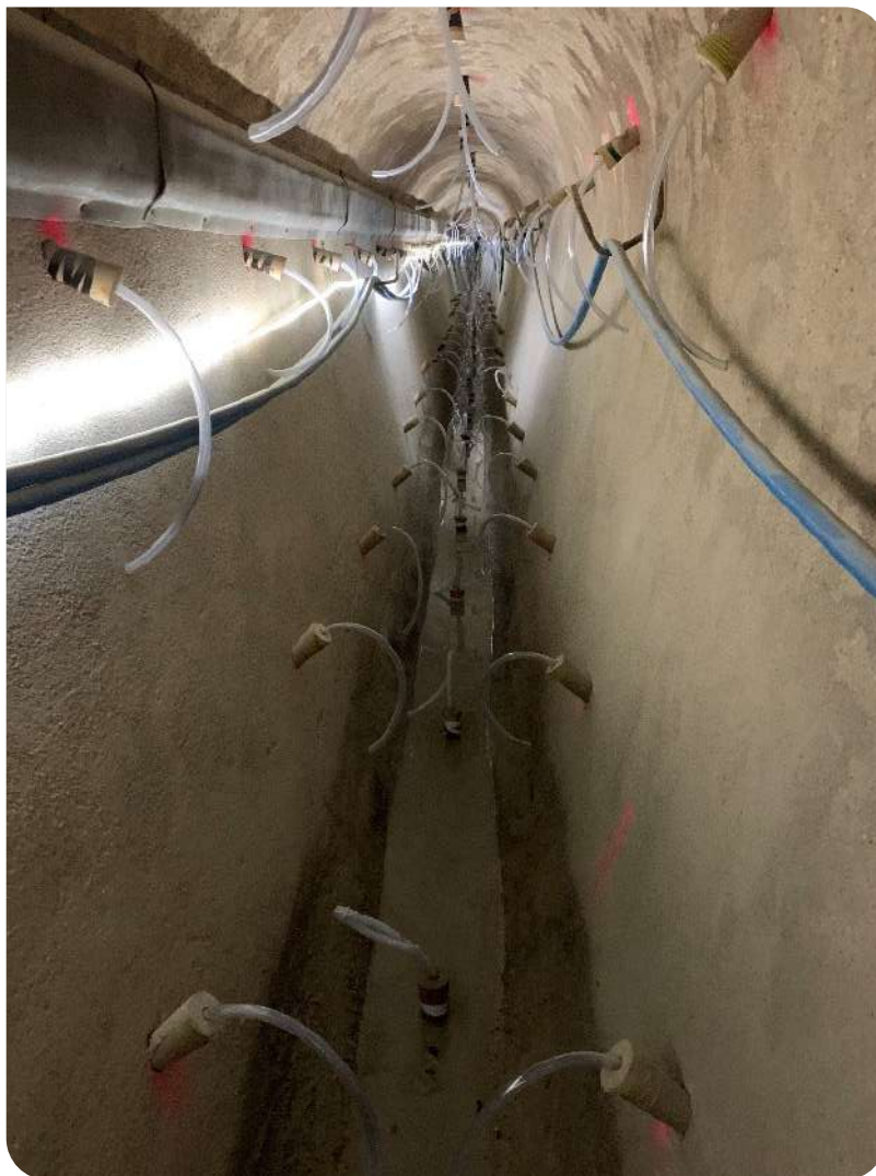
Figure 27 : Travaux d'injection dans le collecteur rue Roguet à Clichy
