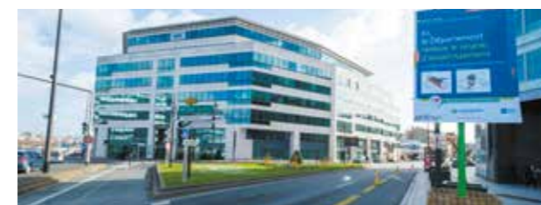
Travaux sur la RD 920, avenue de la Division-Leclerc et avenue Aristide-Briand à Antony (17 février 2022). ©CD92/Willy Labre
