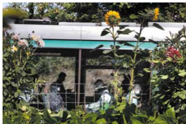
Le Département réduit au maximum l'impact des travaux d'équipement sur le milieu naturel. ©CD92/Olivier Ravoire
