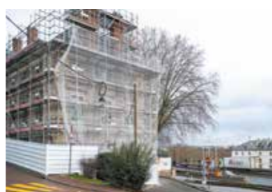
Travaux à Saint-Cloud, sur le site des anciennes écuries Malaquais, pour la création de logements étudiants. ©CD92/Olivier Ravoire
